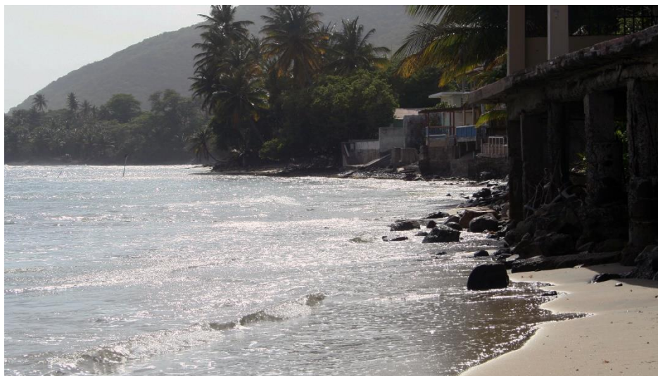
Foto 15. Erosión costera en Patillas
