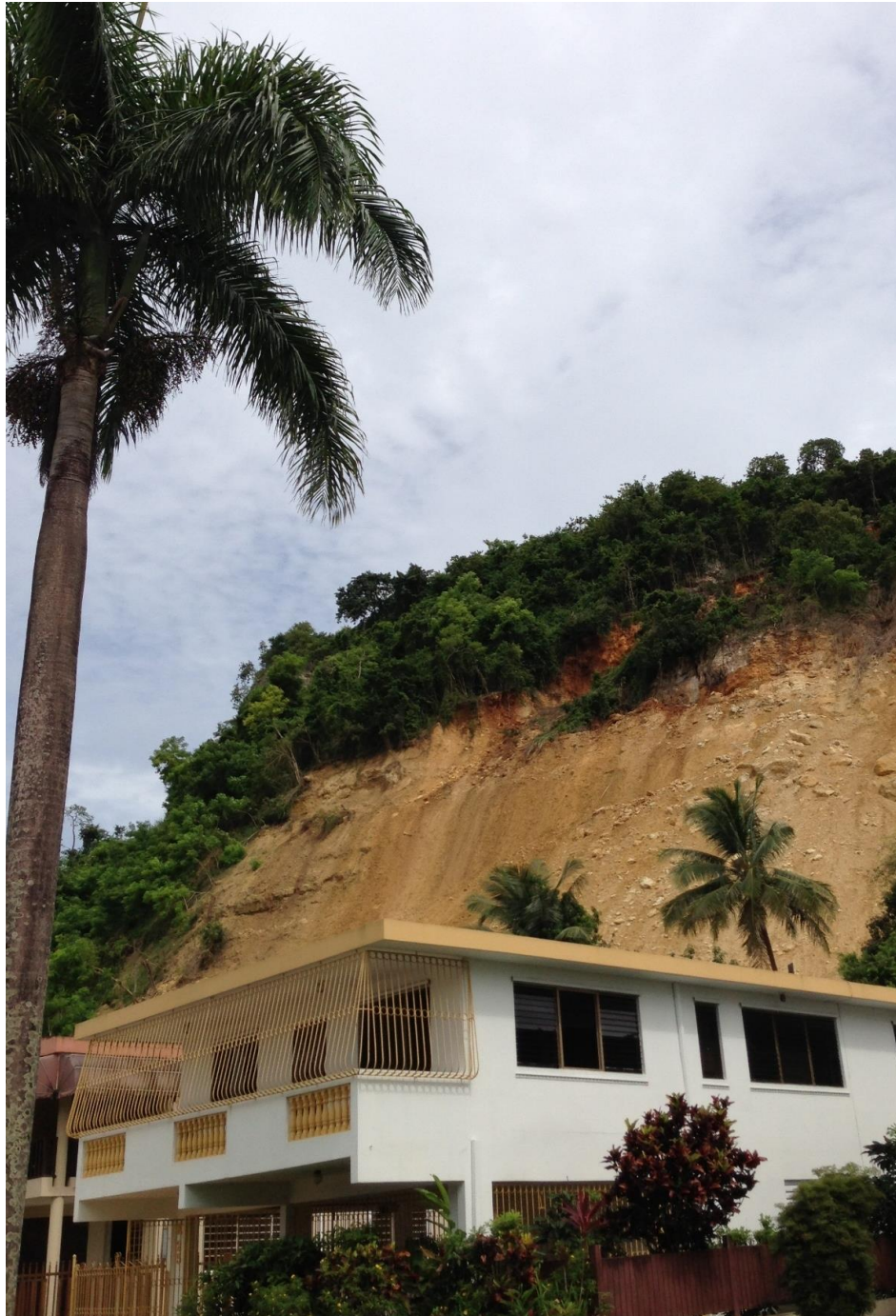
Foto 16. Derrumbe de mogote en urbanización Villa España en Bayamón
