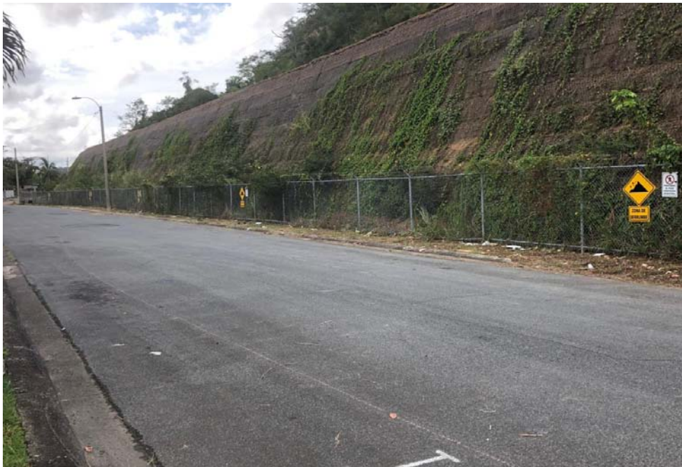
Imagen 2-20: Proyecto de Mitigación Construido Luego del Deslizamiento de Villa España
