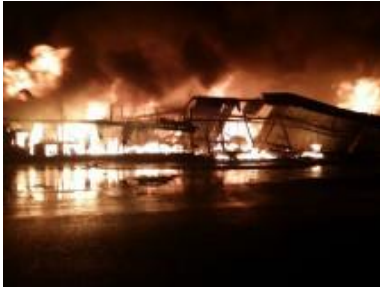
Imagen 2-24: Incendio en Mueblería de Hato Tejas (2014)
