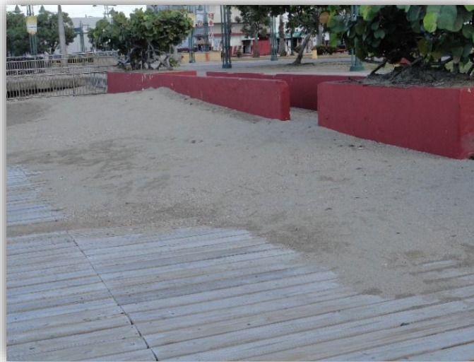
Foto 6: Erosión en el antiguo malecón de Cataño (H. Rivera-2014)
