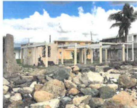
Imagen 2. Estructura con daños severos en la Zona Costera de Punta Santiago.
