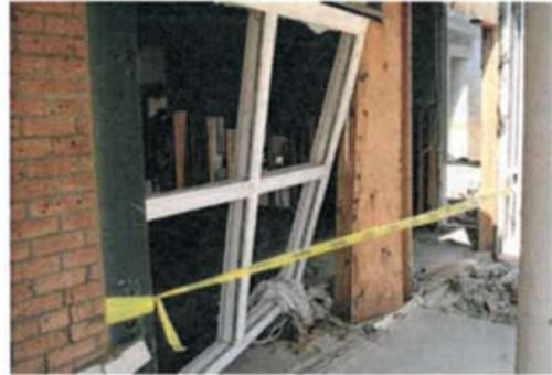
*Imagen 3. Fallo de la pared con marco de madera, de la chapa de ladrillo y de las ventanas debido a 4 pies de inundación de agua tranquilas y olas pequeñas. Huracán Katrina en Misisipi.*
