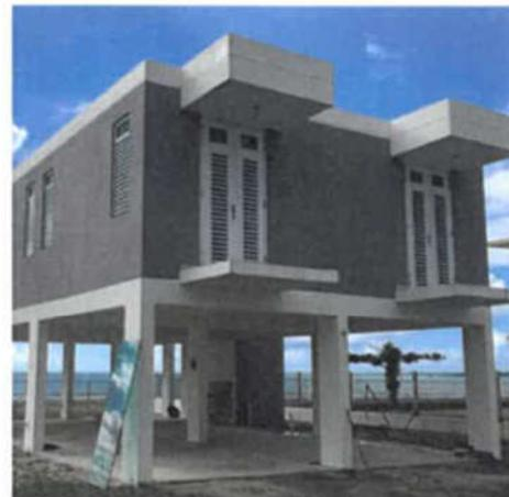
Imagen 12. Una estructura costera bien construida con su elemento más bajo sobre el BFE.
