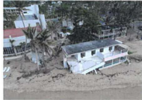
Imagen 1. Falla de la estructura sujeta a oleaje, olas y erosión.
