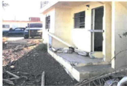
*Imagen 4. Fallo de cimientos tipo Zona A en un área costera, no sujeta a las condiciones de la Zona V.*
