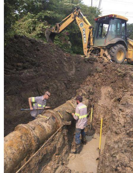
**Figura 8.1. Ejemplo de la técnica de rehabilitación conocida como “excavación y reemplazo”.**
