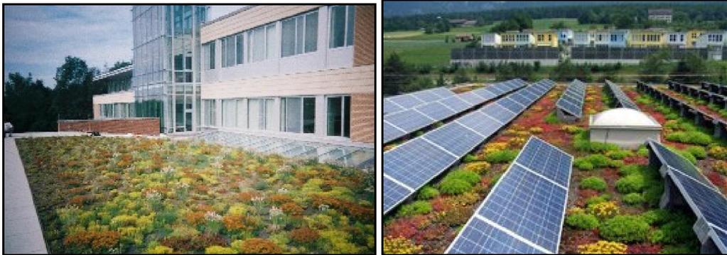
**Ejemplos de naturación urbana en techo y naturación integrado con paneles solares.**
