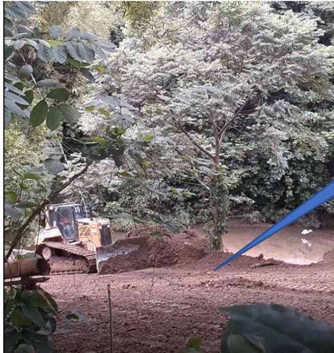
Remoción de corteza vegetal y movimiento de tierra
