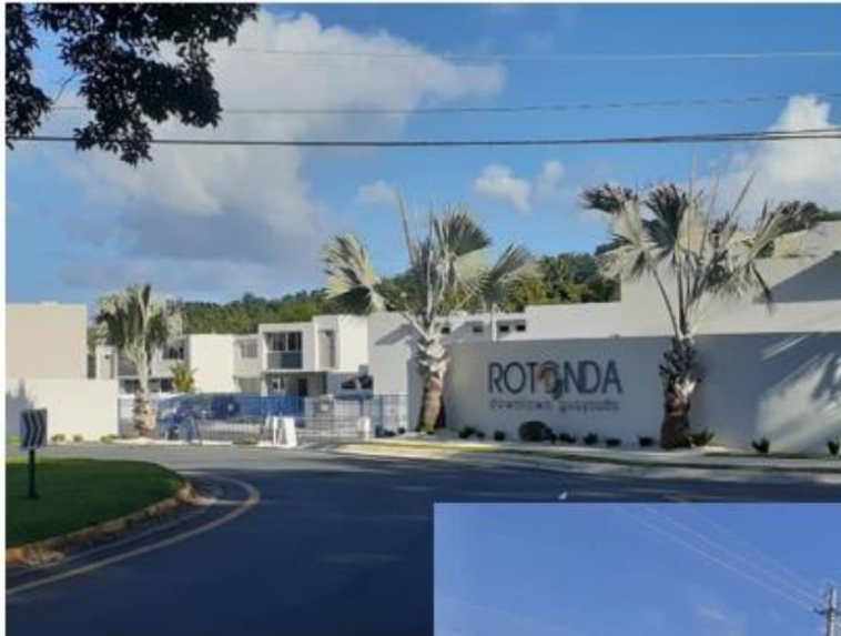
Verja colocada sobre el Puente eliminando la visibilidad.
