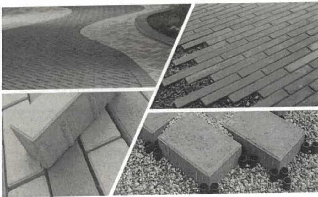
Figura 10.23 Bloques y adoquines de hormigón para pavimento permeable.
