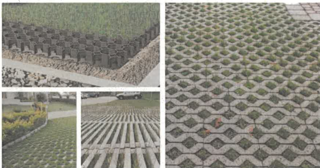
Figura 10.24 Pavimentación con césped o gravilla con refuerzo
