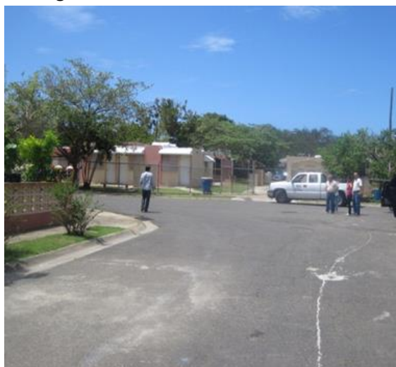
Figura 25. Intersección entre las calles Tulipán y C, donde ocurren eventos de inundación frecuentes
