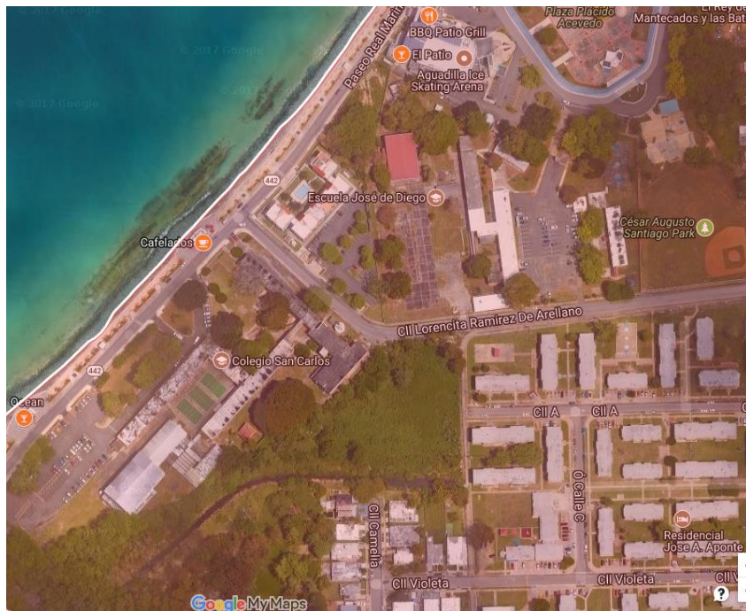
Figura 11. Estructuras e infraestructura dentro de la huella de desalojo de tsunami: Colegio San Carlos, Esc. José de Diego, Edificios del Residencial José Aponte y el Aguadilla Ice Skating Arena
