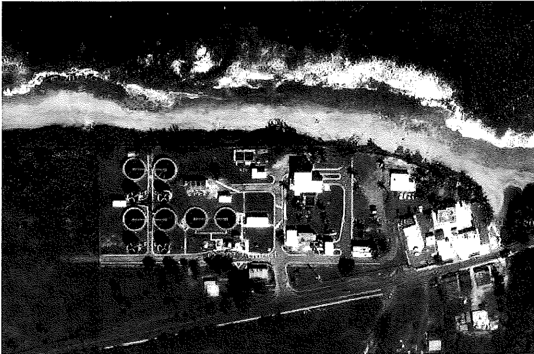
Figura 21: Planta de Tratamiento en Municipio de Camuy – Vista de satélite
