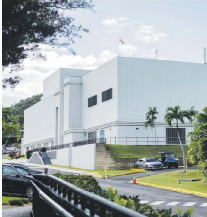
Uno de los factores decisivos para la movida fue que la instalación de Manatí tiene unos 350,000 pies cuadrados disponibles y "la infraestructura necesaria".
