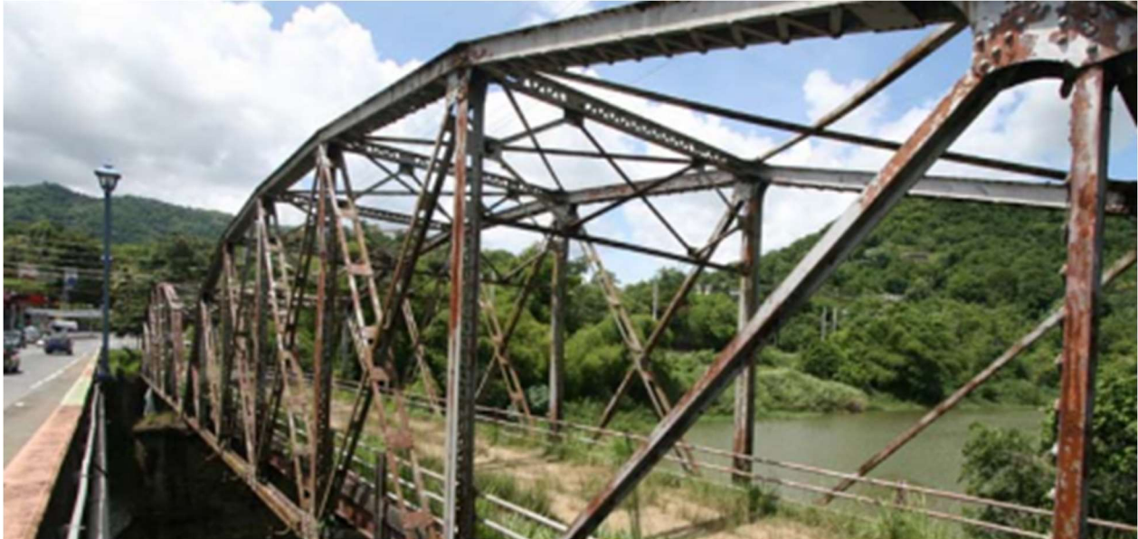
Imagen 6: Puente La Plata
