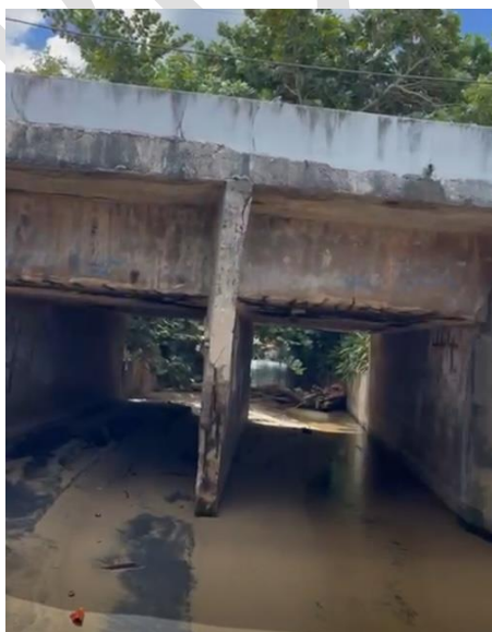
Figura 28. (a)(b) Condición actual del puente
