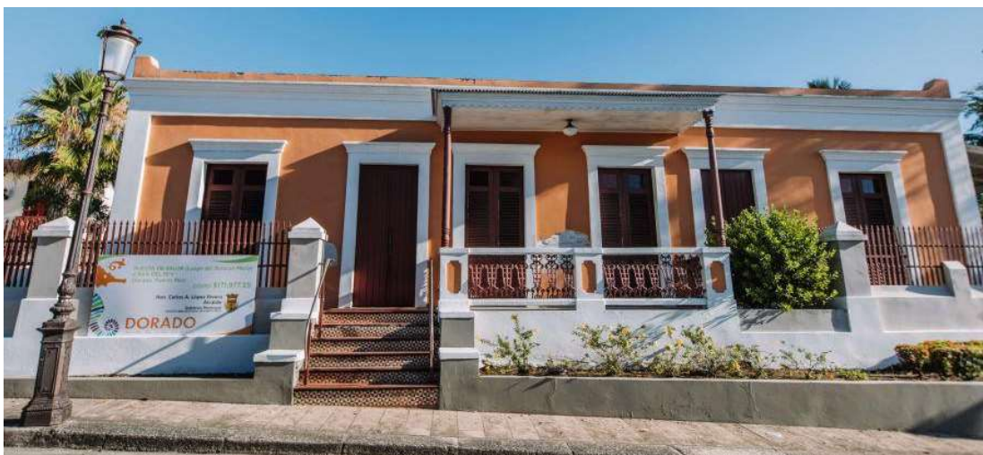
Imagen 2: Fachada Frontal de la Casa del Rey
