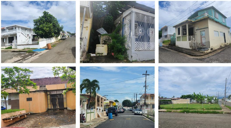
Foto 17. Estructuras en Comunidades Especiales Las Arizonas y San Felipe
