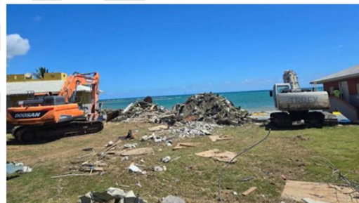
Locales. Comienza demolición de Centro Vacacional de Arroyo afectado por los pasados desastres naturales. (Suministrada.)
