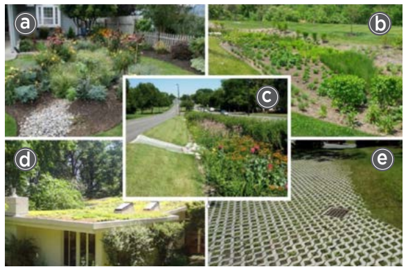
Prácticas de desarrollo de bajo impacto LID: a) Jardín pluvial; b) Estanque de biorretención; c) Zanja vegetada; d) Techo verde; e) Pavimento permeable.
