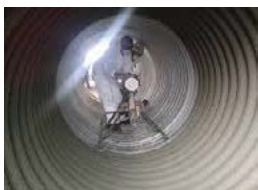
Revestimiento centrifugado de concreto para reparar tubos pluviales defectuosos. Se muestra el aplicador (spincaster).
