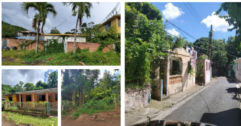
Foto 14. Viviendas abandonadas en Patillas
