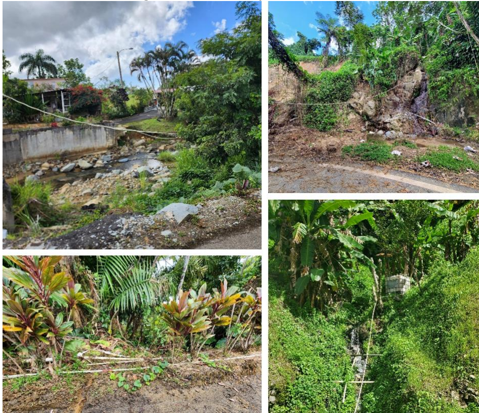
Foto 21. Tomas de aguas comunitarias para uso residencial en Patillas
