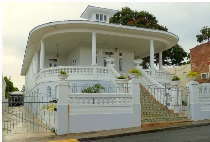
Imagen 4: Fachada Frontal Residencia Berta Sepúlveda
