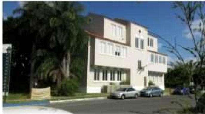
Imagen 4: Vista de Estructura del Antiguo Pueblo del Niño
