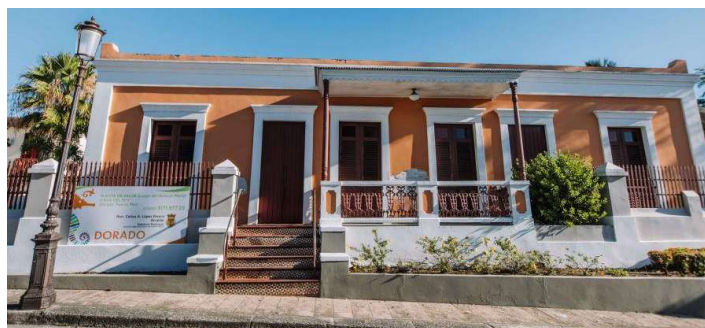
Imagen 2: Fachada Frontal de la Casa del Rey
