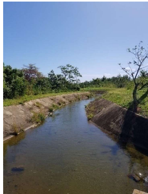
Canal de riego Foto tomada por ETI, 2020
