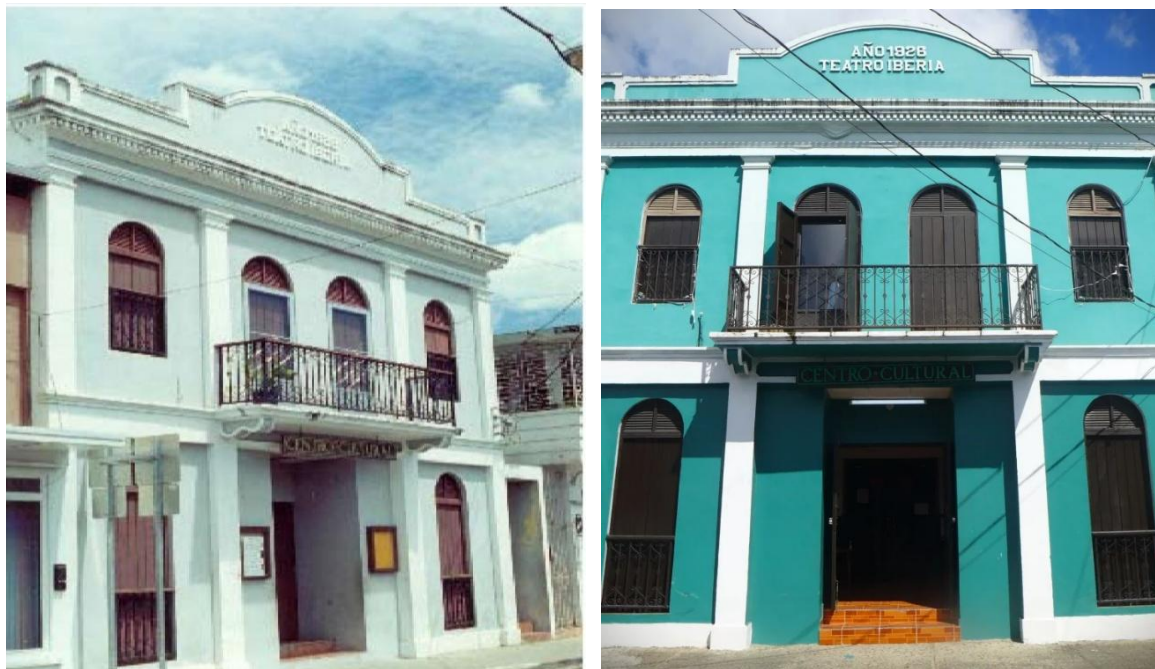
Figura 4 : Fotos de la Fachada del Antiguo Teatro Iberia
